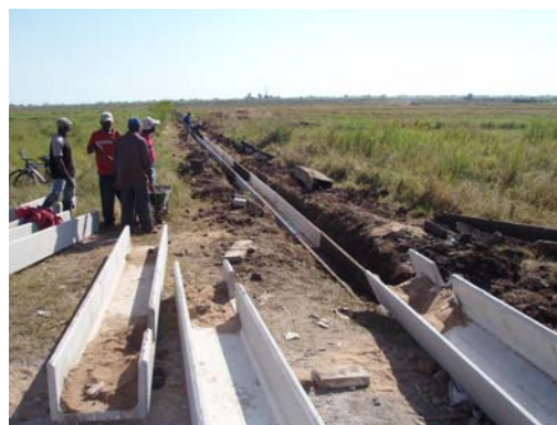
灌漑水路の修復作業 2007年
