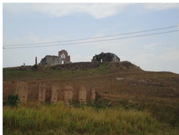
写真:ウガンダ国境近くの町キヤカにある破壊された教会跡地。この先にある橋も破壊されたが、今は復旧している。
